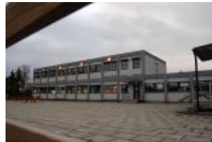
Strandens skola är snart ett minne blott. Modulerna och en del andra byggnader ska tas bort för att ge plats för annan exploatering. Arkitekttävlingen kan ge svar på vad det blir. Foto: Hans Olander
